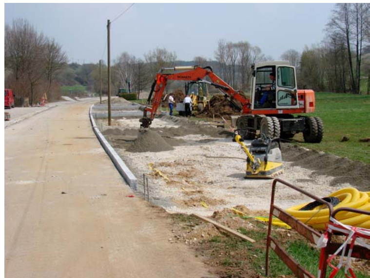
Die Fa. Keckl, Deining, ist momentan mit dem Bau der neuen Parkplätze beim Friedhof beschäftigt.
